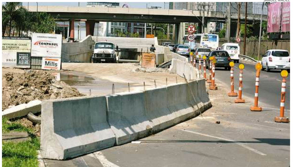
Trincheira na Ceará, com 300 metros de extensão e custo de R$ 32 milhões, deveria ser concluída em dezembro deste ano
