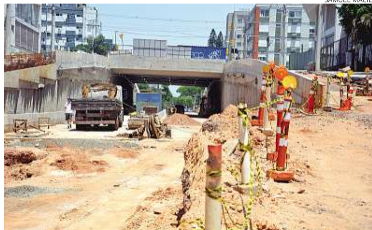
Alças de acesso, muro de contenção e calçadas devem ficar prontos em 2017
